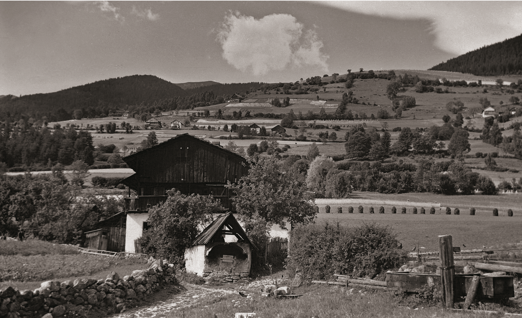
Hofansicht von der Talseite, dahinter der Hang von Oberissing, genannt Honigberg, Aufn. Atzwanger 1940
