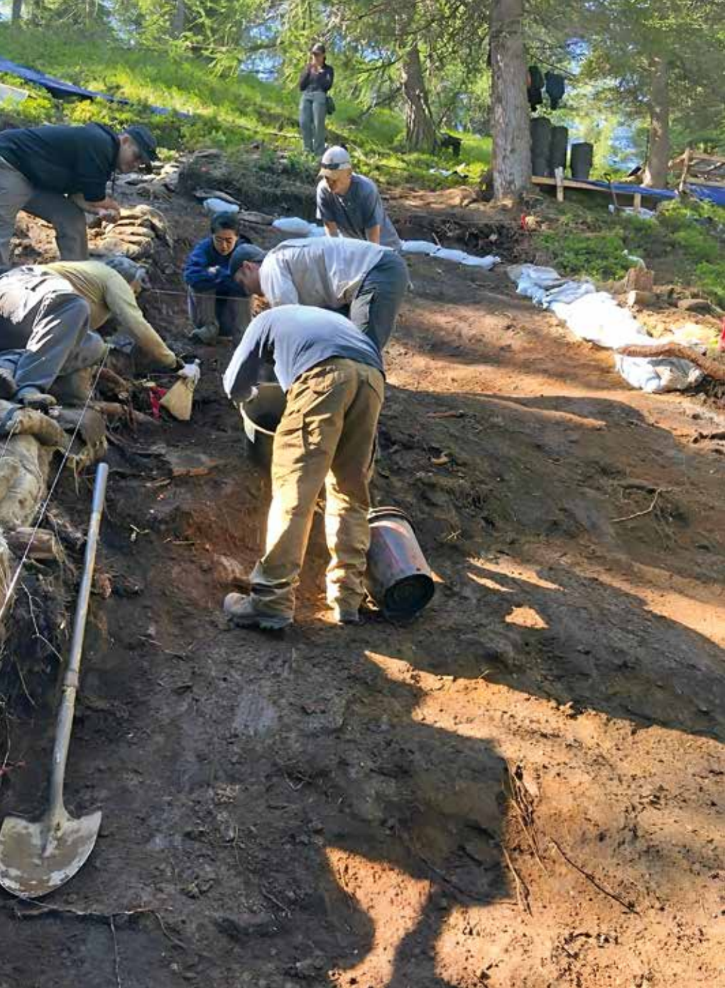
Quadrante dieci nella seconda fase di lavorazione
