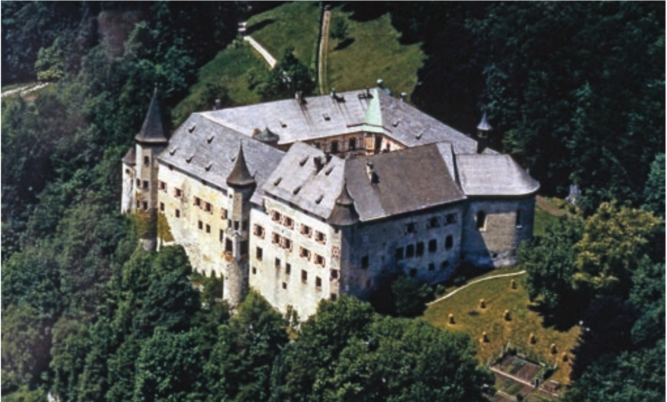
Abb. 10: Tratzberg, Luftaufnahme von Südosten, um 1990.
