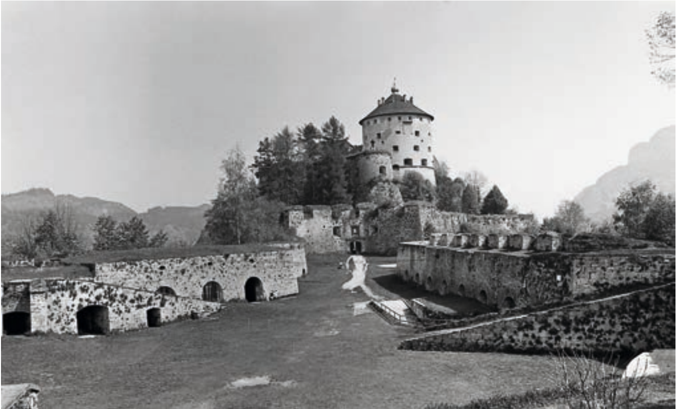
Abb. 9: Kufstein, Blick von der Josefsburg gegen Nordosten zu Pfauenschweif, Carolibastion und Kaisersturm. Zustand vor Entfernung des Pflanzenbewuchses an den Mauerzügen und Bastionsflächen, vor 1975.
