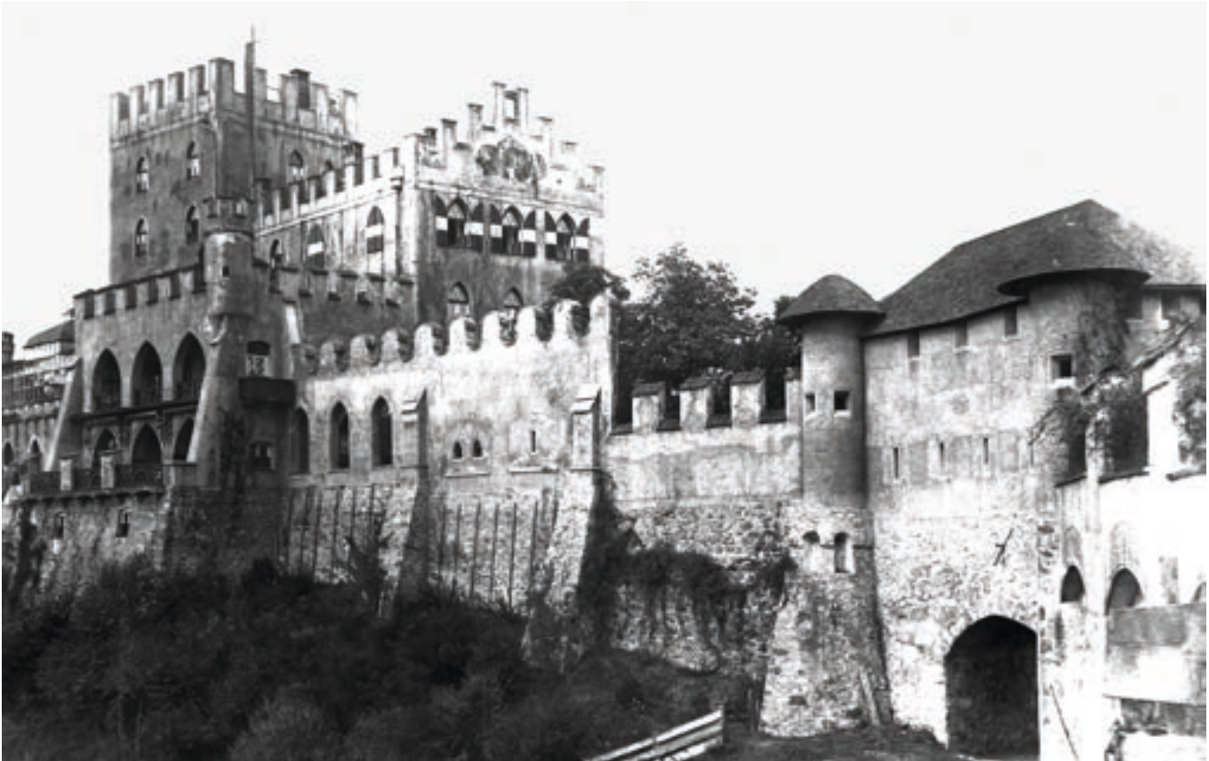
Abb. 11: Itter, Ansicht von Südosten, 1900–1920.
